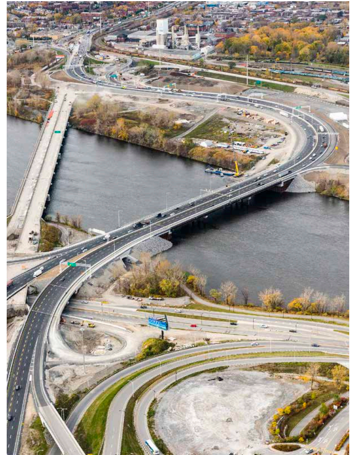
Pont de contournement de l'Île des Sœurs
